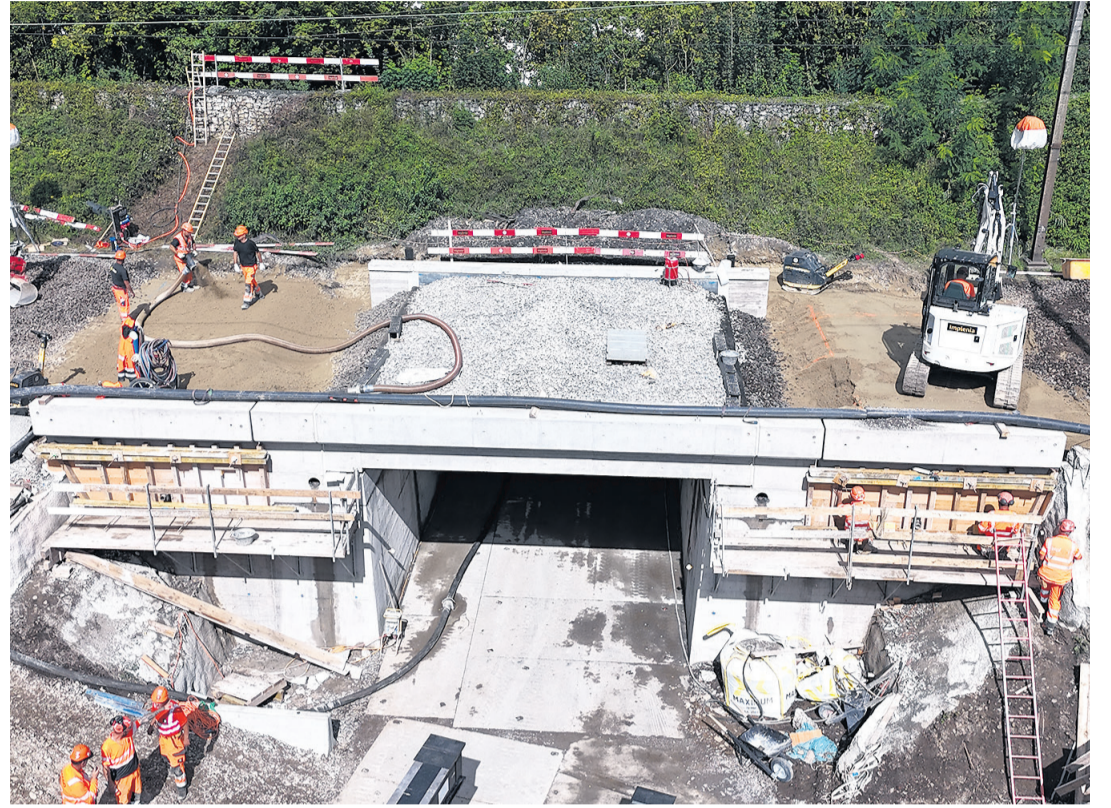
Die alte Brücke musste Platz machen, damit die neuen Brückenelemente eingeschoben werden konnten. Alles hat, gemäss SBB, wie geplant geklappt.
