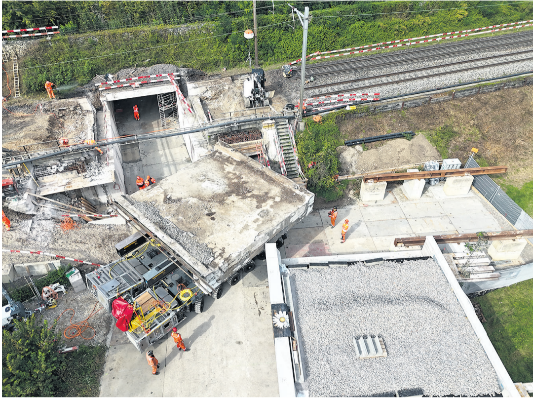
Die alte Brücke musste Platz machen, damit die neuen Brückenelemente eingeschoben werden konnten. Alles hat, gemäss SBB, wie geplant geklappt.
